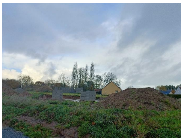
Lotissement en cours de réalisation
