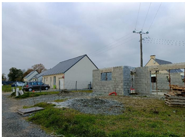
Lotissement en cours de réalisation
