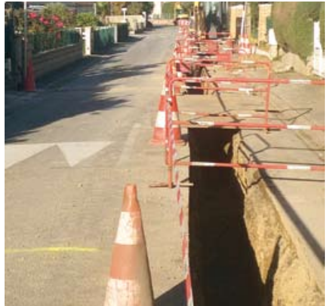
Enfouissement des réseaux rue du Vieux Château.
