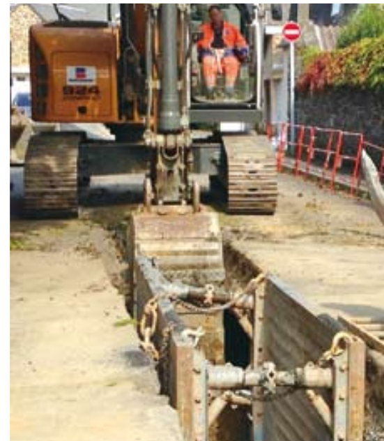
Sécurisation du réseau d'eau pluviale.
