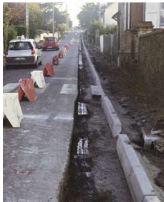
Sécurisation piétonne et routière rue Charles Mathurin.
